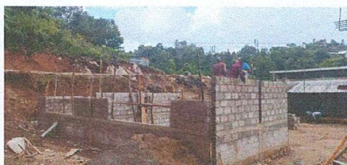
Foto 2: Colocacion de Block de piedra.
