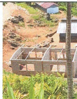
Foto 4: Vista panoramica colocacion de tijeras y costaneras de cubierta.
