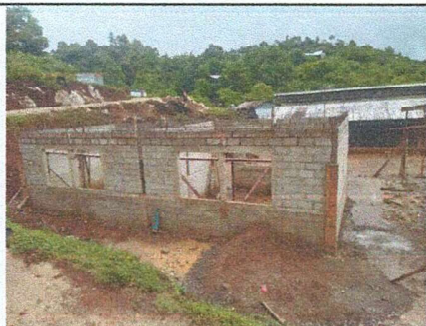
Foto 3: Fundicion de columnas y soleras de módulos.
