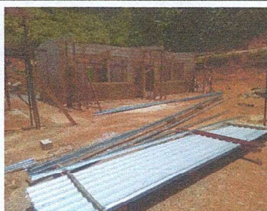
Foto 5: Colocacion de Costaneras e instalacion de laminas troqueladas.
