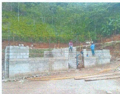
Foto1: Inicio de trabajos de rehabilitación de dos módulos.
